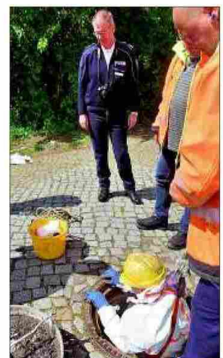
Mitarbeiter der SWM prüften den Abwasserkanal. Fotos (3): Uli Lücke
