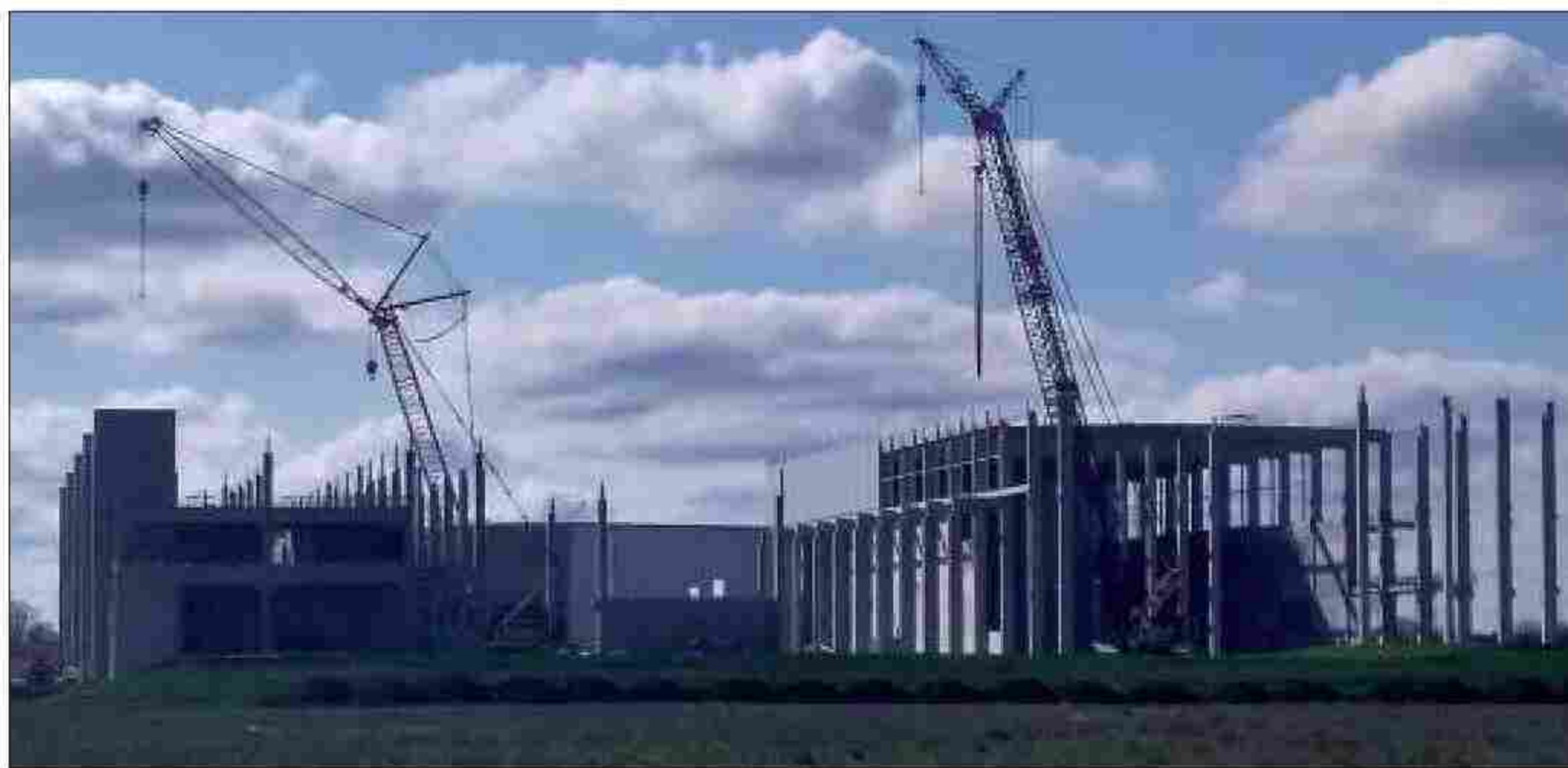
Auf der Baustelle für Rewe wird geklotzt und nicht gekleckert.
