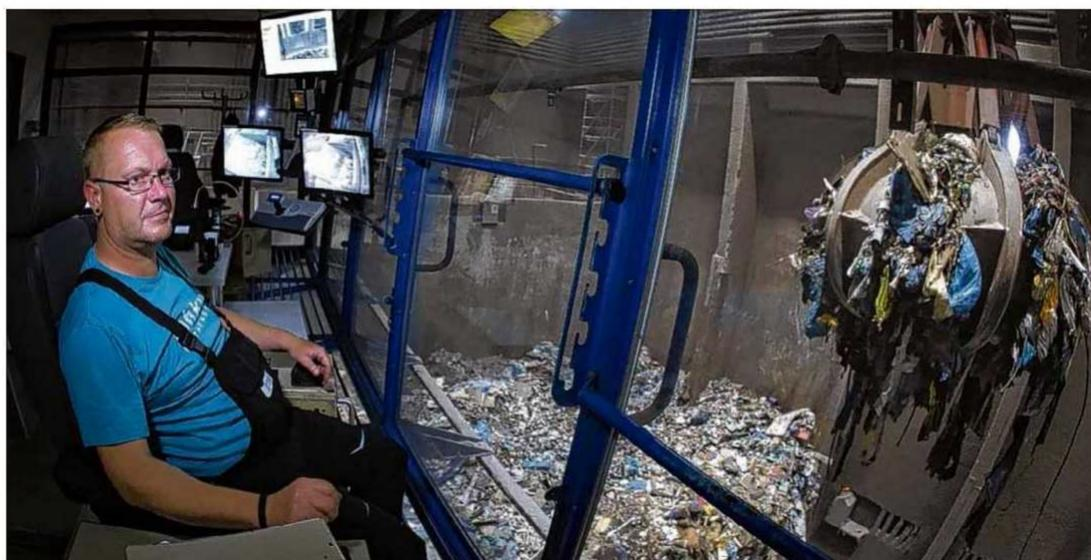
Kranfahrer Andy Brandt manövriert einen elektrohydraulischen Greifer im Abfallbunker des Müllheizkraftwerks Rothensee. In dem Werk werden aus Abfall Strom und Wärme. Fotos (3): Ronny Hartmann/dpa
