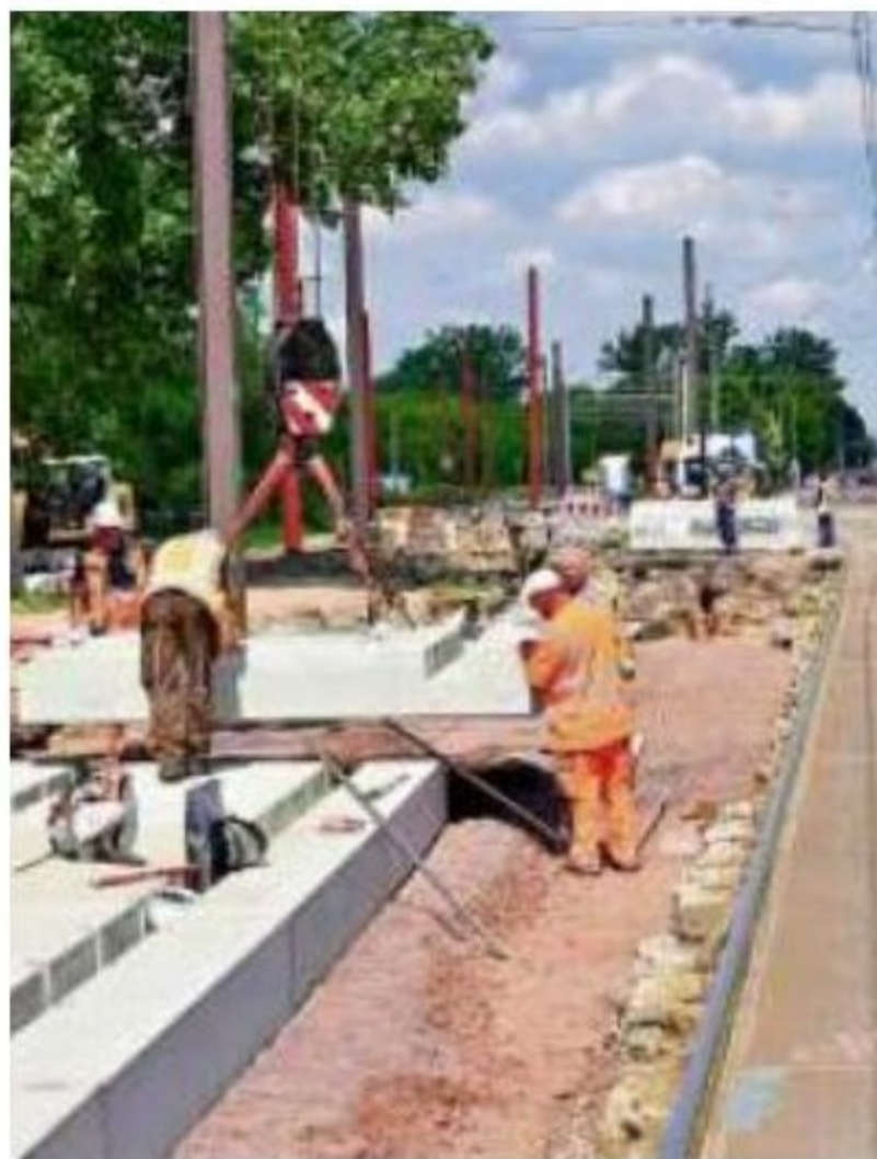
Auf dem August-Bebel-Damm wird bereits seit 2021 gearbeitet. FOTO: LÜCKE
