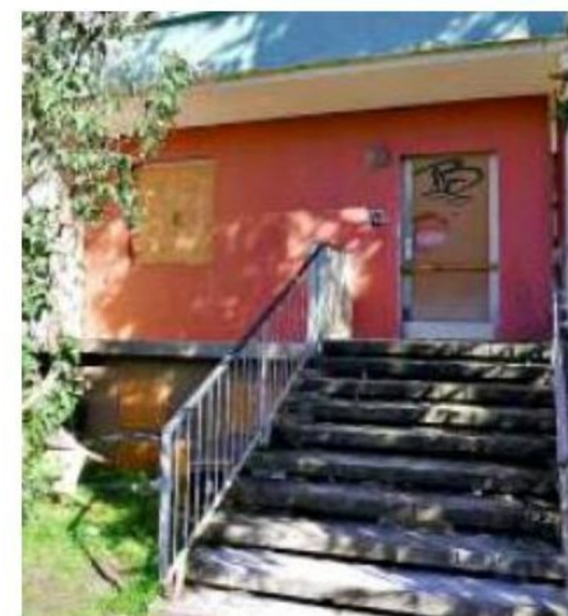
Der mittlere der drei Blöcke steht leer. Die Eingänge sind verbarrikadiert.
