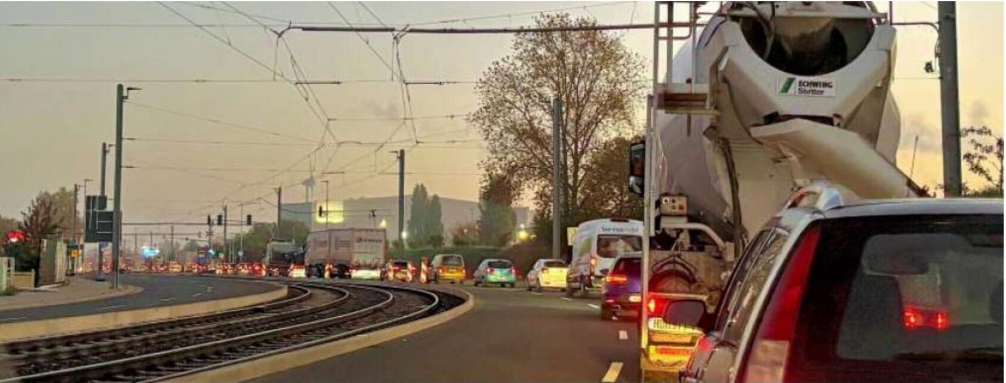
Auf dem August-Bebel-Damm kommt es durch die neue Baustellenampel im Bereich der Gleisbaustelle der MVB zu Staus.
