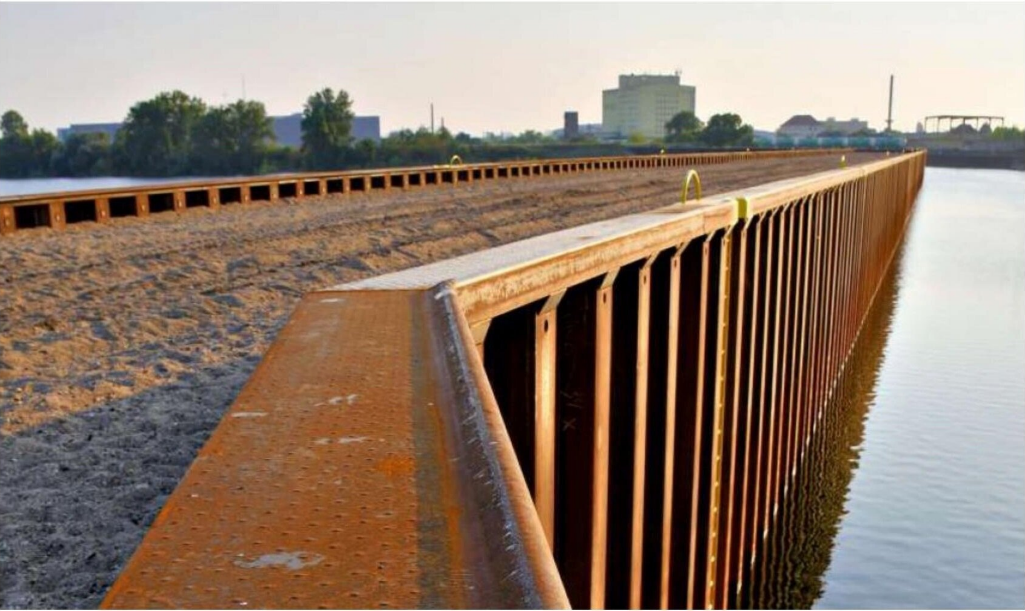
Der neue Fangedamm im Industriebahnhof spielt auch beim Hochwasserschutz für den Stadtteil Rottensee eine wichtige Rolle.
