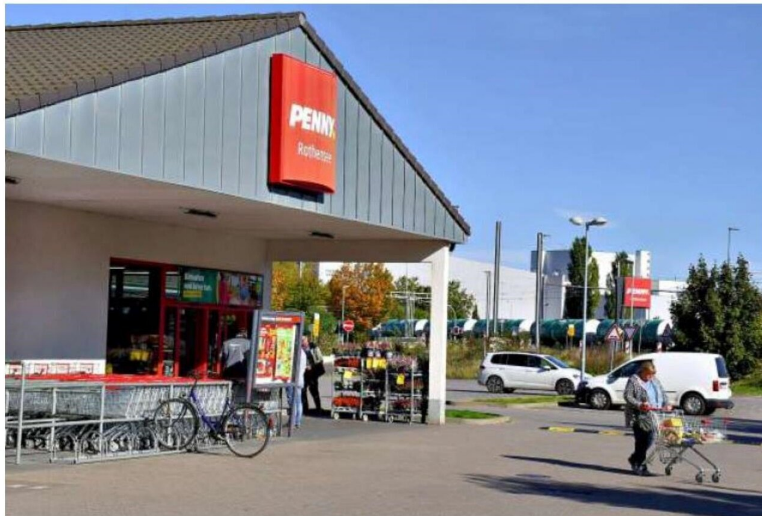
Der Penny-Markt an der Rothenseer Scheidebuschstraße schließt Anfang November wegen Umbauarbeiten. Mehrere Wochen lang gibt es im Stadtteil dann keinen Nahversorger.
