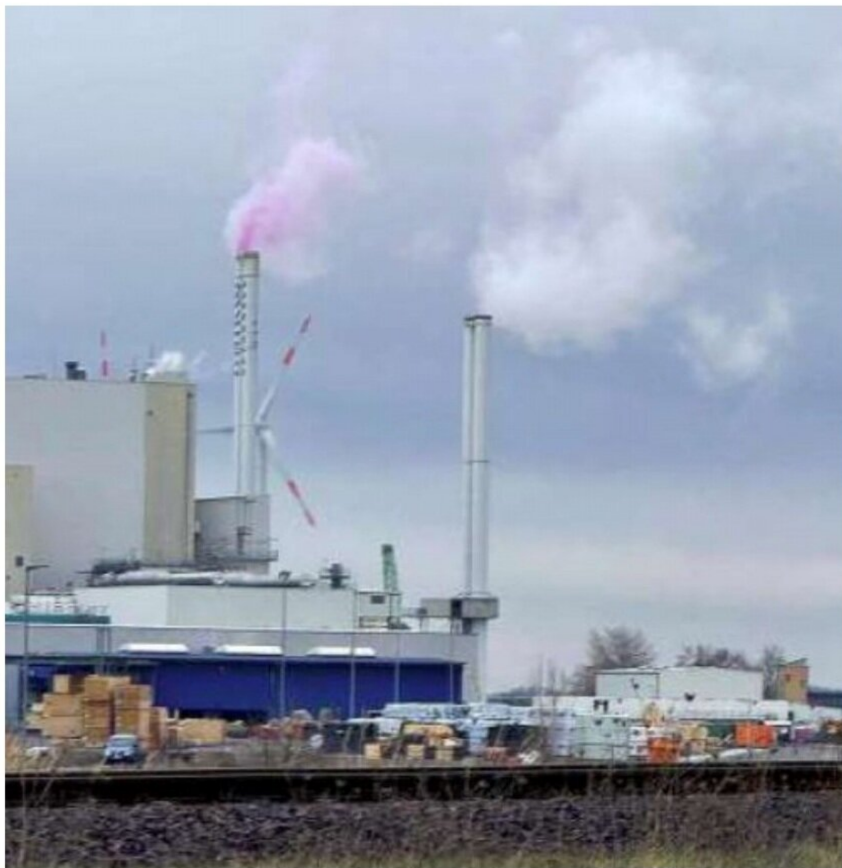
Mitte Januar kam aus dem Müllheizkraftwerk Rothensee rosa Rauch (links). Krankenhausabfälle mit Jod sollen die Ursache gewesen sein.
