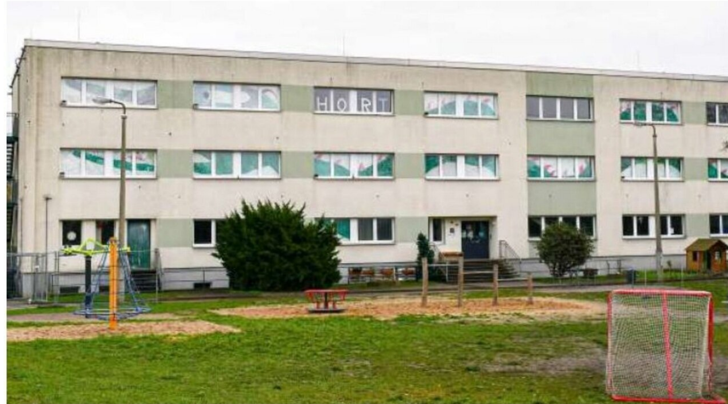
Erst Asylbewerberunterkunft, dann Hort und jetzt Obdachlosenheim? Die Stadtverwaltung will im Gebäude an der Windmühlenstraße das zentrale Angebot für wohnungslose Menschen unterbringen.
