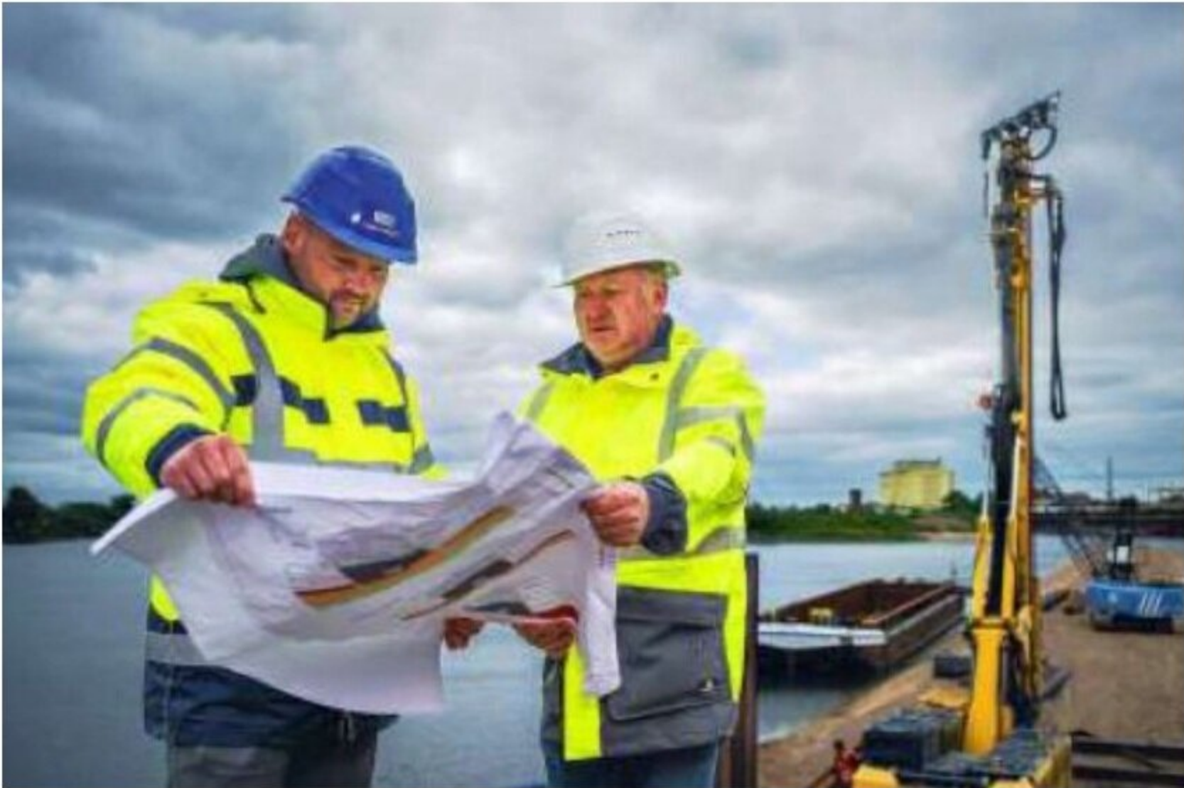
Oberbauleiter Niko Wulf und Bauleiter Martin Neubauer im Industriehafen Magdeburg.
