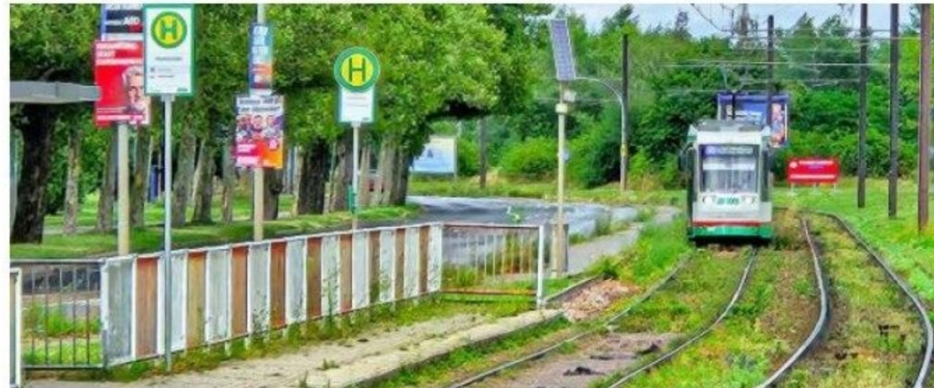
Blick auf den Teil des August-Bebel-Damms, der im Zuge der Erneuerung des Straßenbahn-Asts Nordost für die MVB verändert werden soll.
