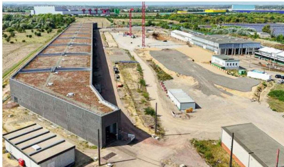
Der MVB-Betriebshof wird seit 2021 umgebaut. Die Baumaßnahmen sollen noch bis 2029 andauern. FOTO: MVB/PETER GERCKE
