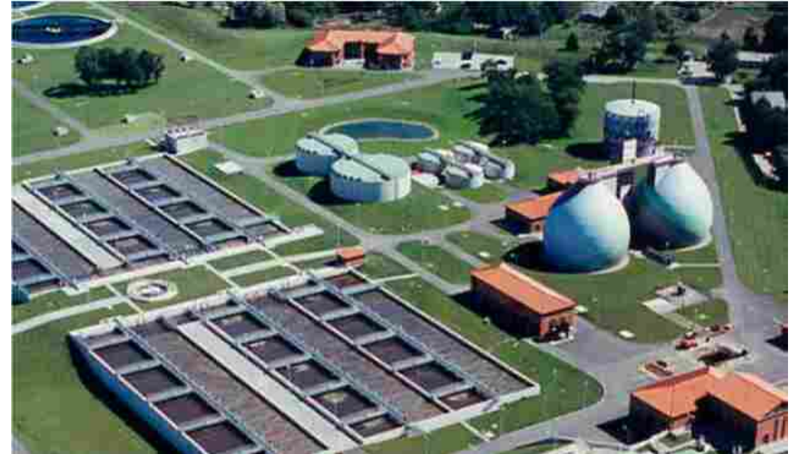
Klärwerk Magdeburg in Gerwisch
