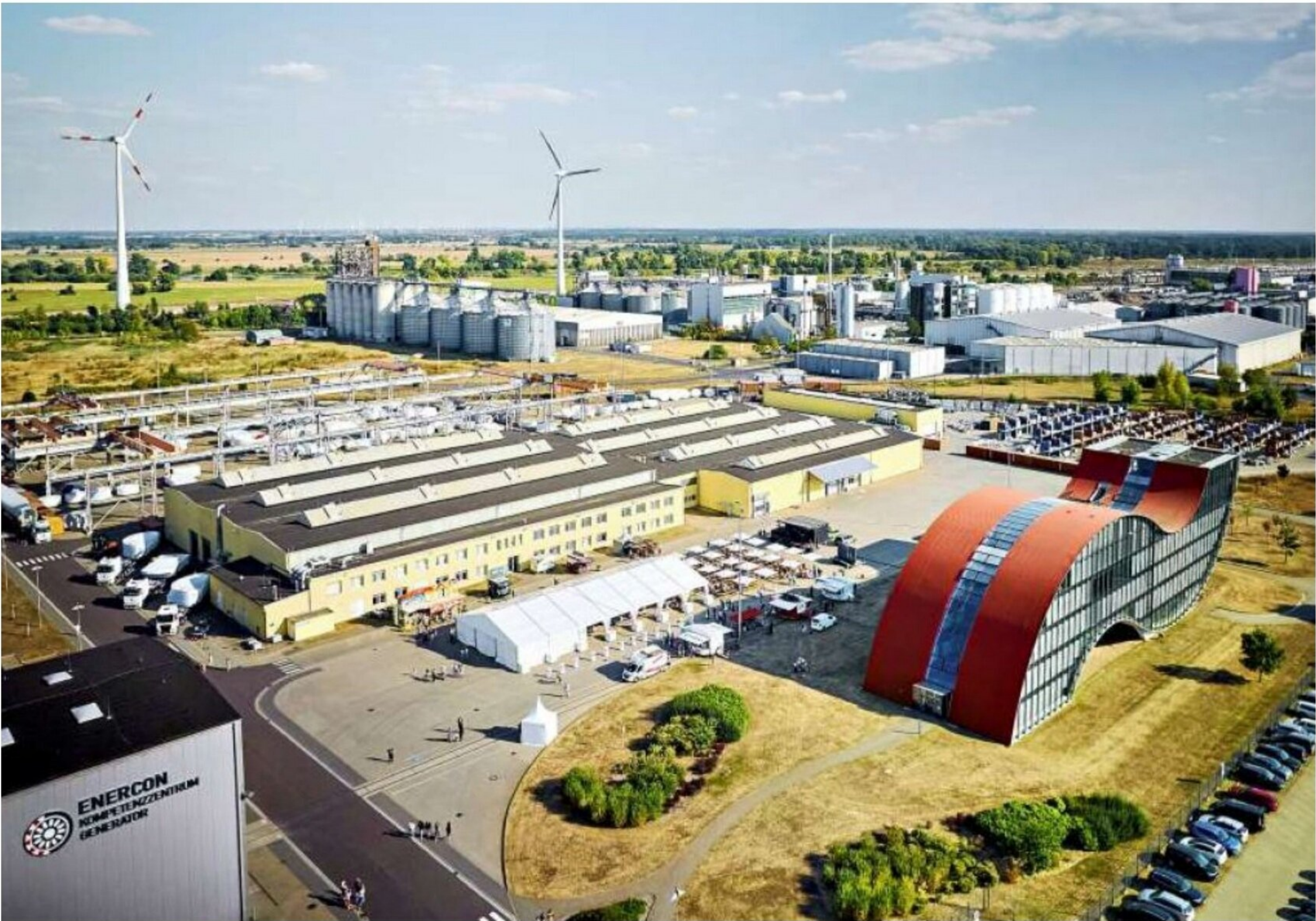
Blick auf den Enercon-Standort im Gewerbegebiet Nord. Hier ist das Kompetenzzentrum Generator des Windradherstellers zu Hause.
