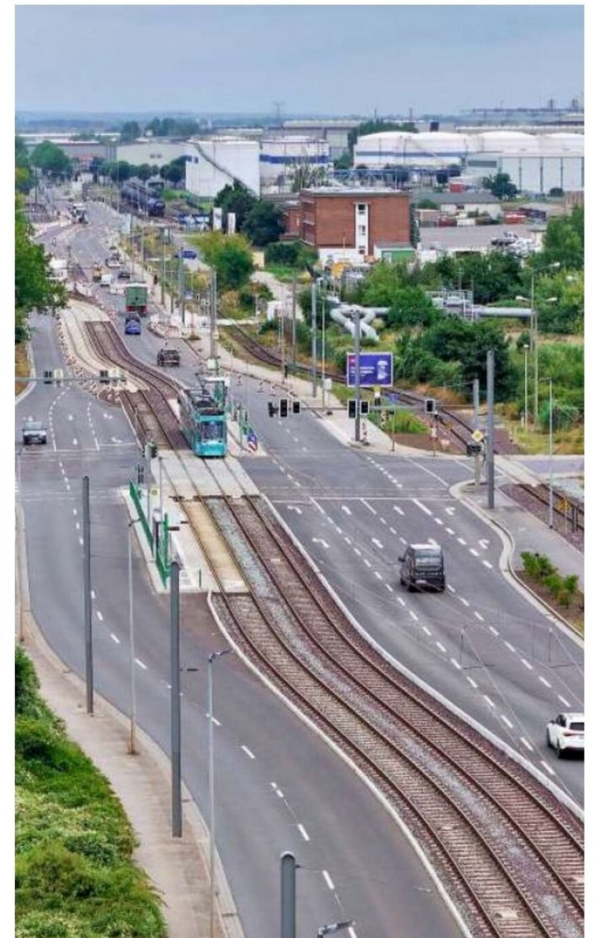
Seit einigen Tagen rollen auf der Straßenbahntrasse zwischen Rothensee und Barleber See wieder die Bahnen. Jetzt wurde das Projekt mit einem offiziellen Termin abgeschlossen.
